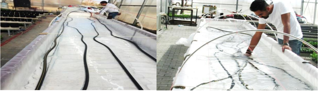
Şekil 6. Termostatlı ısıtma düzeneğinin havuz içerisine yerleştirilmesi
