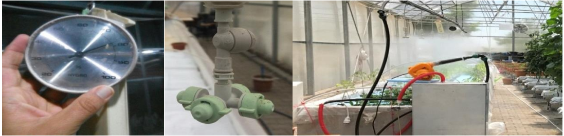
Şekil 17. Nem ölçümü ve kullanılan düşük basınçlı sisleme sistemi
